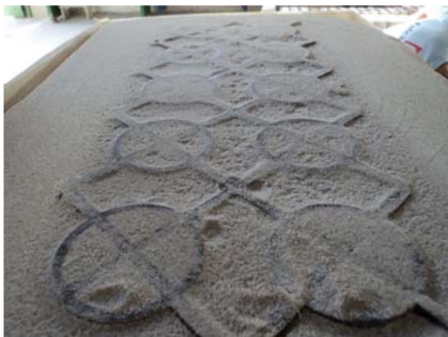
Foto 01 – Ecopavimento preenchido com areia
