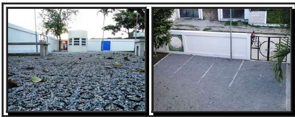
Após o preenchimento com brita
